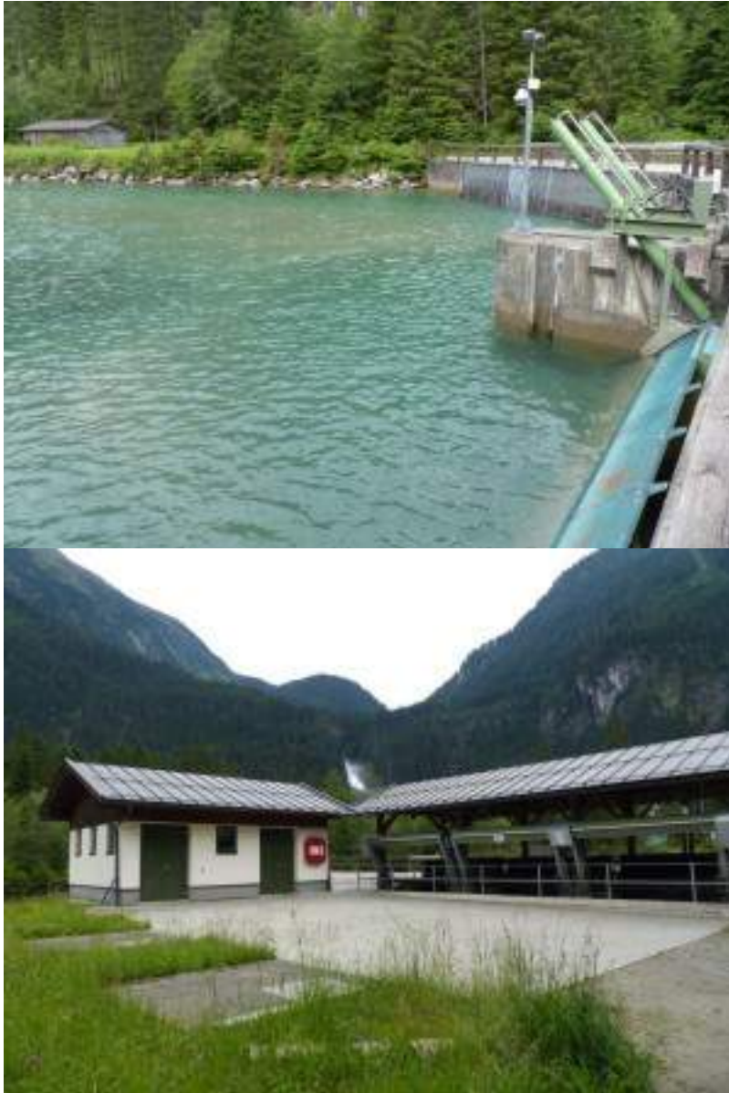
Das stehende Wasser am Staudamm und Teile der gesamten Anlage
